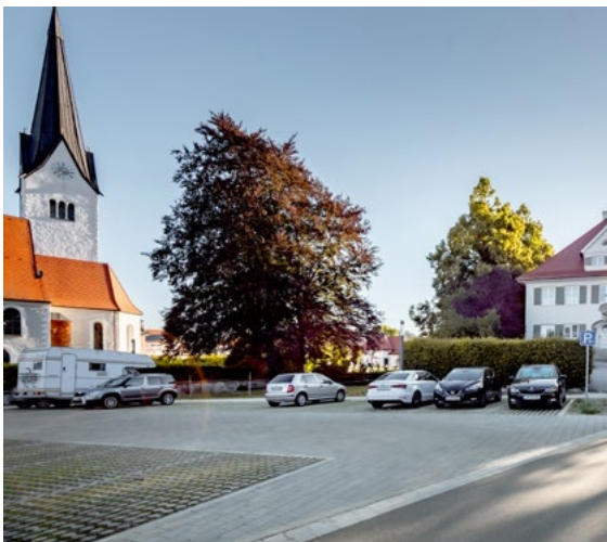
◆ An der Einmündung des Pfarrwegs wurden 17 neue Stellplätze geschaffen und der Gehweg von der Straße wegverlegt.
