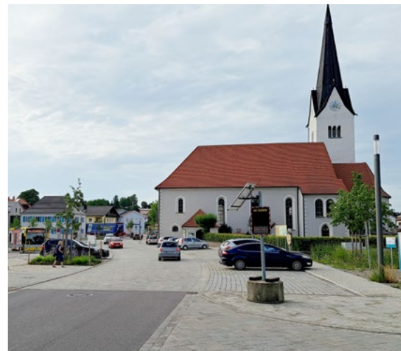
◆ Zwischen Kirche und Gasthof wurde die Kreisstraße mit Granit gepflastert und auch die Linienführung verändert.
