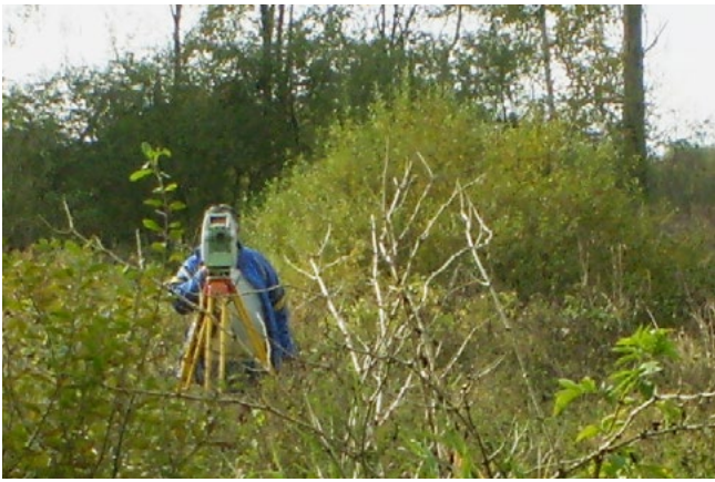
◆ Vermessungsarbeiten im Dattenhauser Ried.
