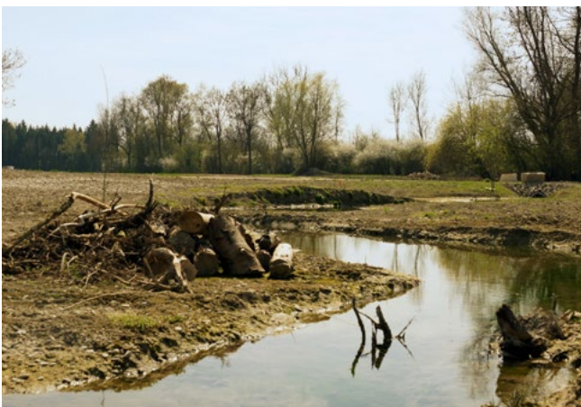
◆ Flutrinne während der Baumaßnahme.
