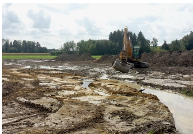
◆ Quellbereich während der Bauphase.
