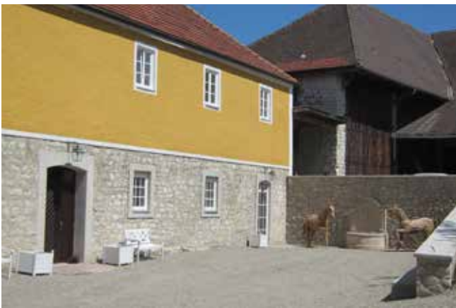
◆ Sanierungsmaßnahmen am Schloss in Tagmersheim
